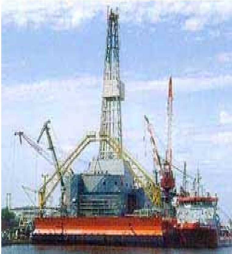
Fig. 1. Drilling barge «Sunkar»
